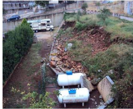
crollò per innalzamento del livello dell'acqua a tergo
