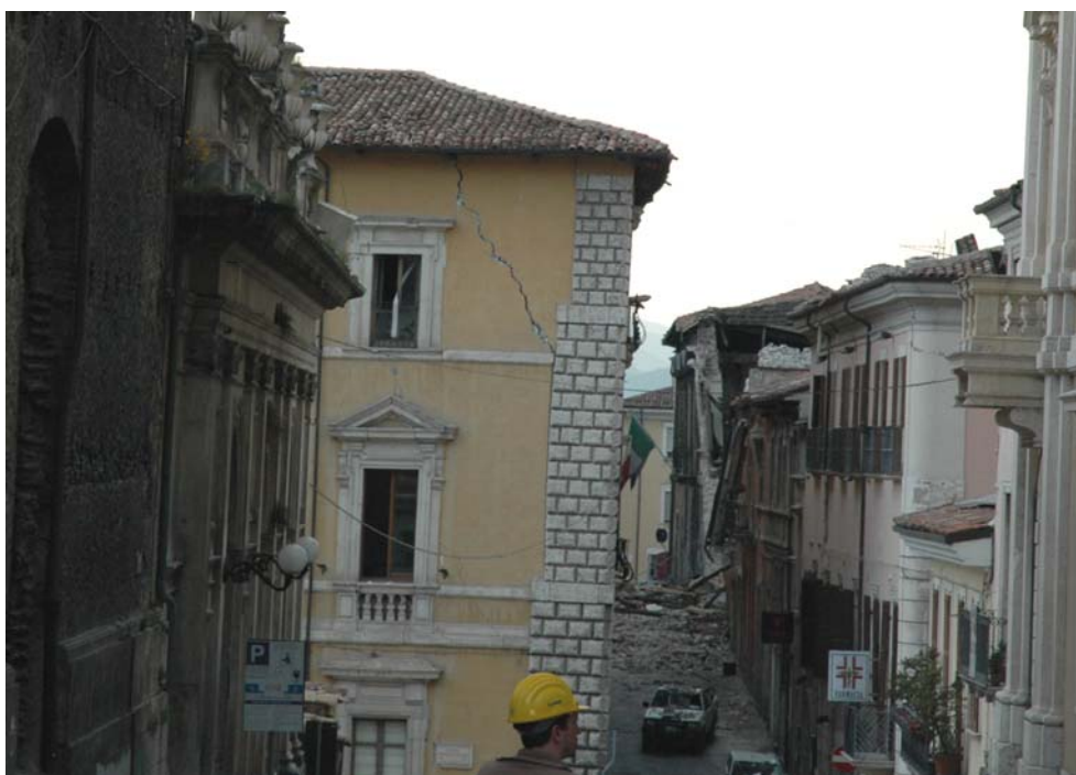
Figura 5. Lesione in pannello murario di sommità dovuta ad attivazione di meccanismo di ribaltamento fuori dal piano del paramento ad esso perpendicolare, grazie al buon ammortamento nello spigolo (by A. Balsamo, I. Iovinella, A. Prota)
